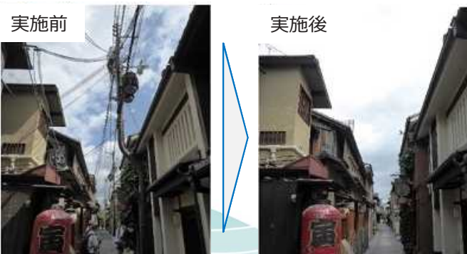
▲地中化工事の実施前と実施後
