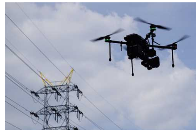
▲ドローン技術を活用した設備点検
