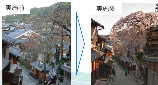
▲地中化工事の実施前と実施後
