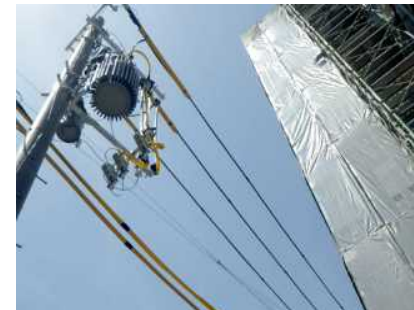
▲ 防護カバーの取り付け
