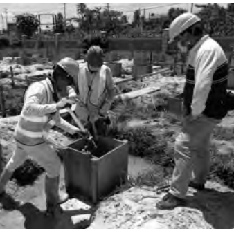
▲現場での基礎工事の様子を視察する柏木さん
