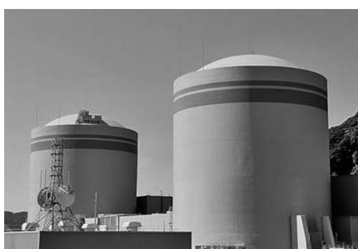
▲手前から高浜発電所1、2号機（写真②）
